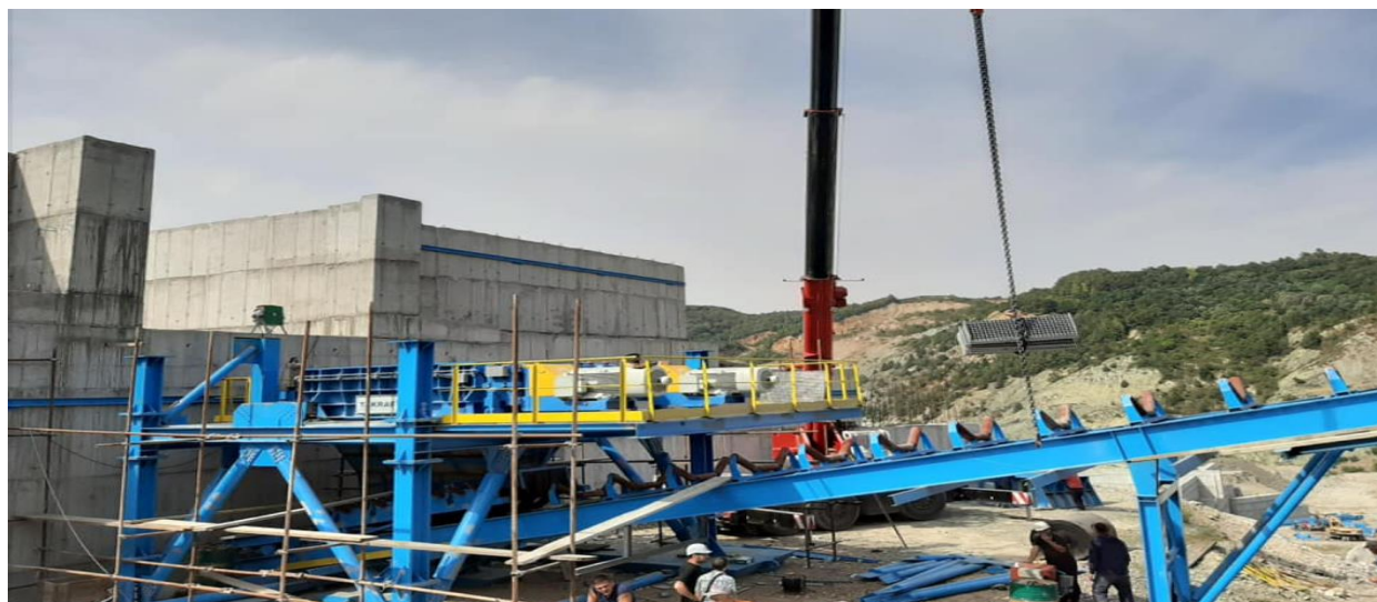
Slika 1. Sklapanje postrojenja za drobljenje otkrivke
