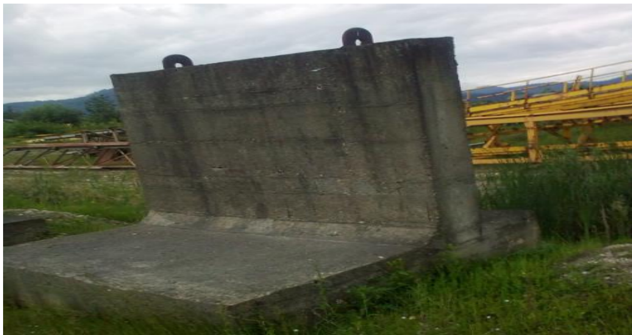
Slika 11. Sidrena posuda - armirano betonski blok
